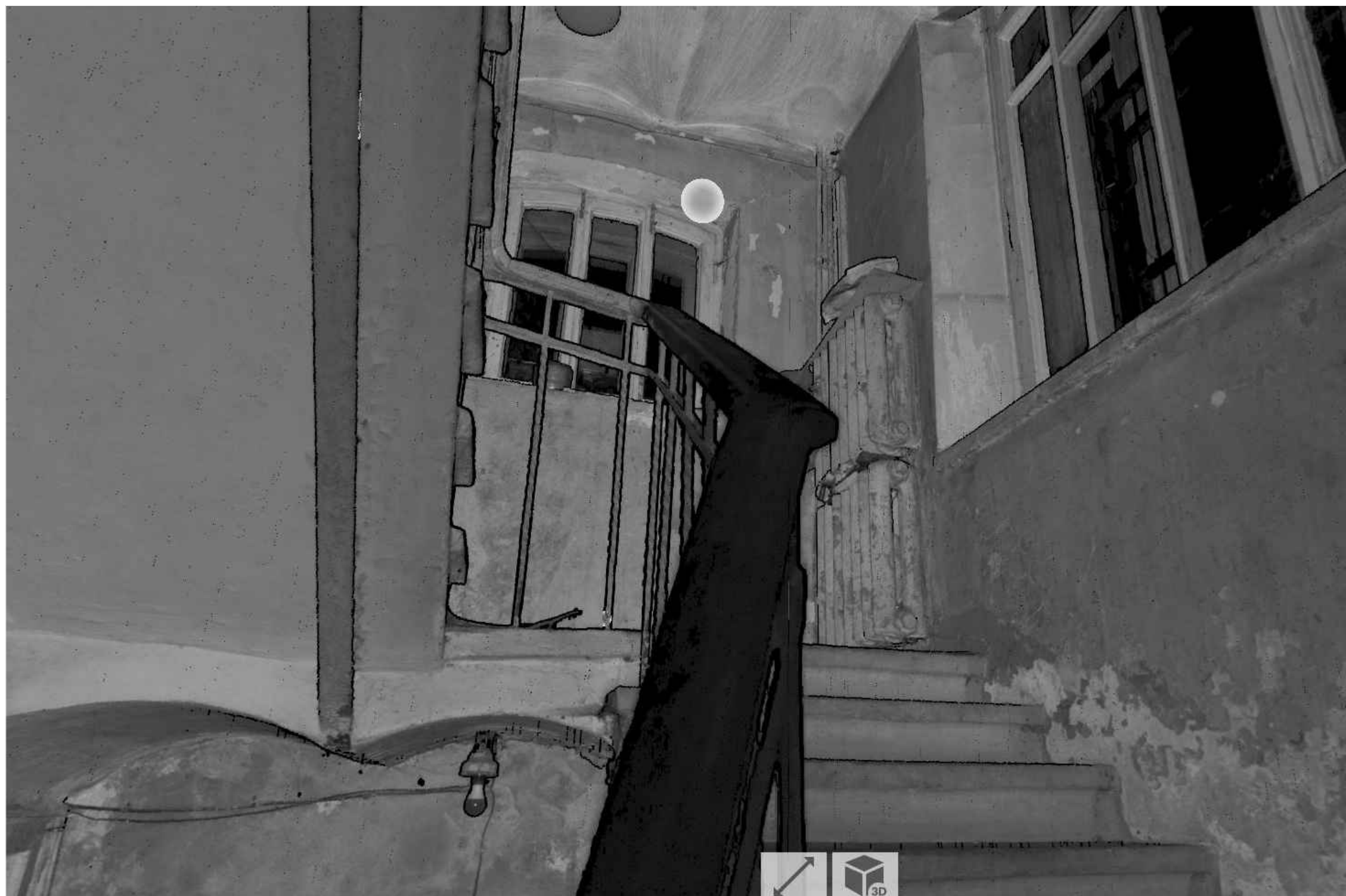
Вид 10. Помещение лестницы № 213.
